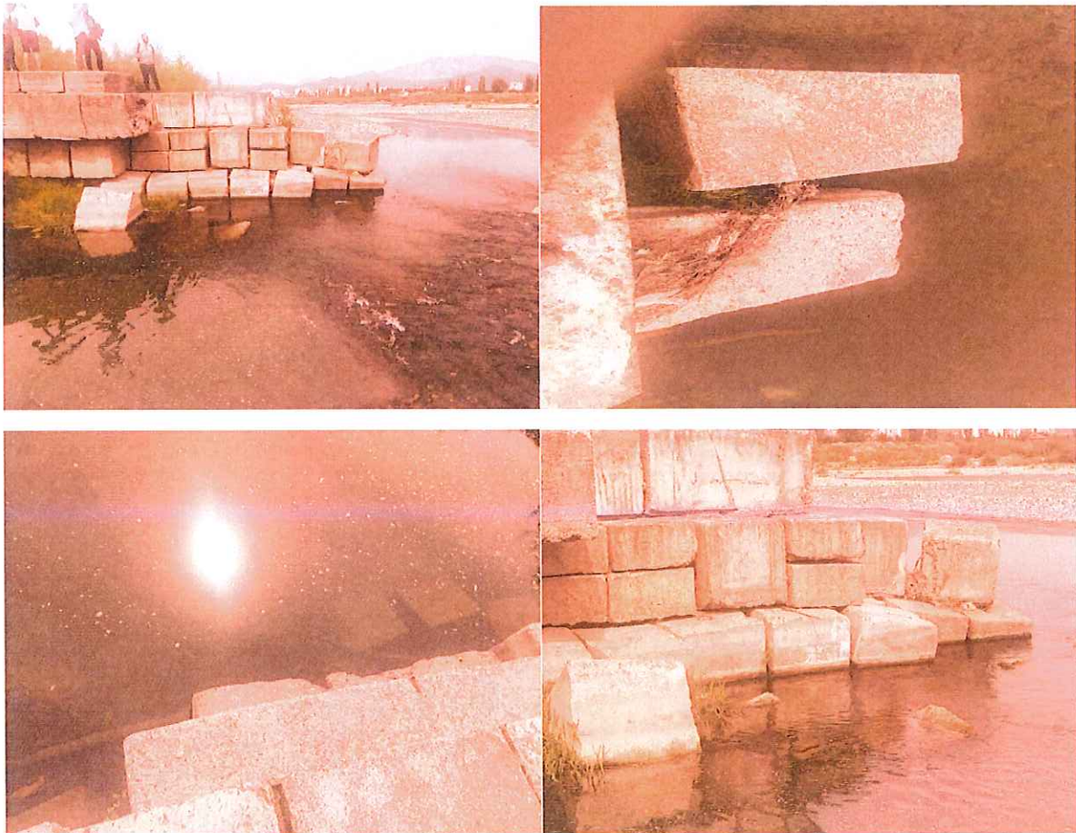
Figura. 2 Gjendja ekzistuese e masave mbrojtese në lumin Shkumbin
