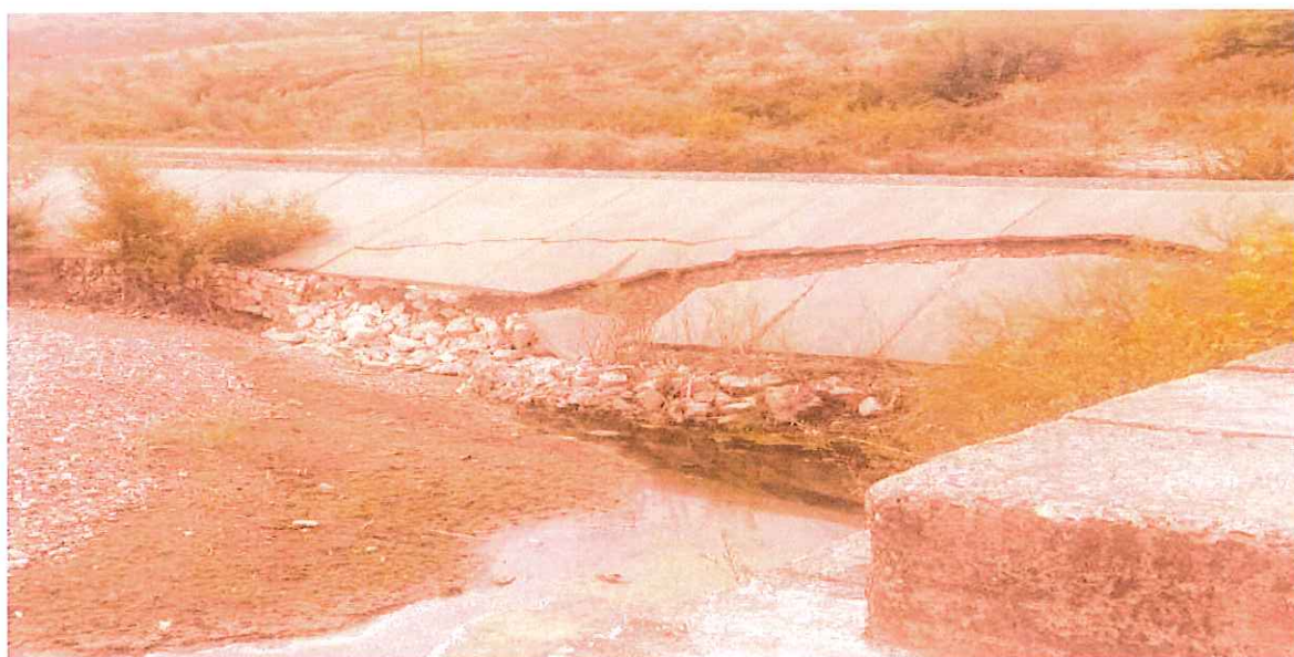
Figura. 2 Gjendja ekzistuese e masave mbrojtese në lumin Shkumbin
